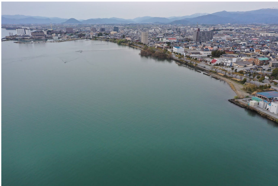
図－3 2025年現在の長浜市下坂浜町沖の状況（空撮）、右端に良疇寺の境内がある。
