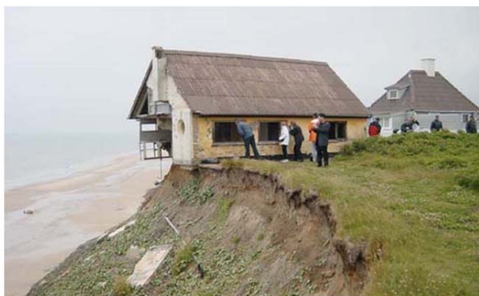
図1 海岸侵食による人工構造物の被害例
